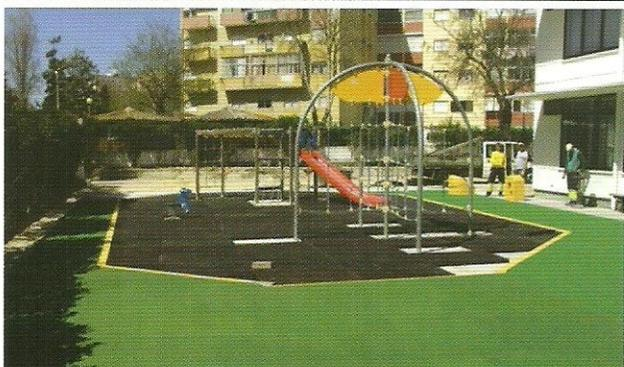
Arranjos exteriores junto ao parque infantil EB1 Monte Belo – Substituição das cordas, execução de caixa, pinturas no pavimento e colocação do pavimento de segurança.
