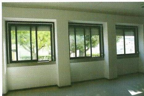
Substituição completa da caixilharia na EB1 da Fonte do Lavra
