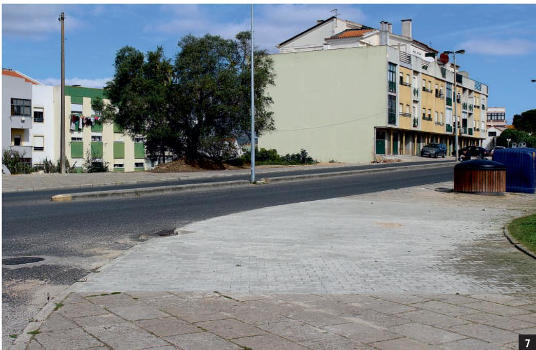
Um troço do pavimento pedonal da avenida da Bela Vista, junto ao cruzamento com a rua Gil Eanes, que se encontrava abatido, com muitas falhas e bastante degradado, foi requalificado através da remoção do pavimento degradado, constituído por lajetas, e do assentamento de novos blocos de pavê.
