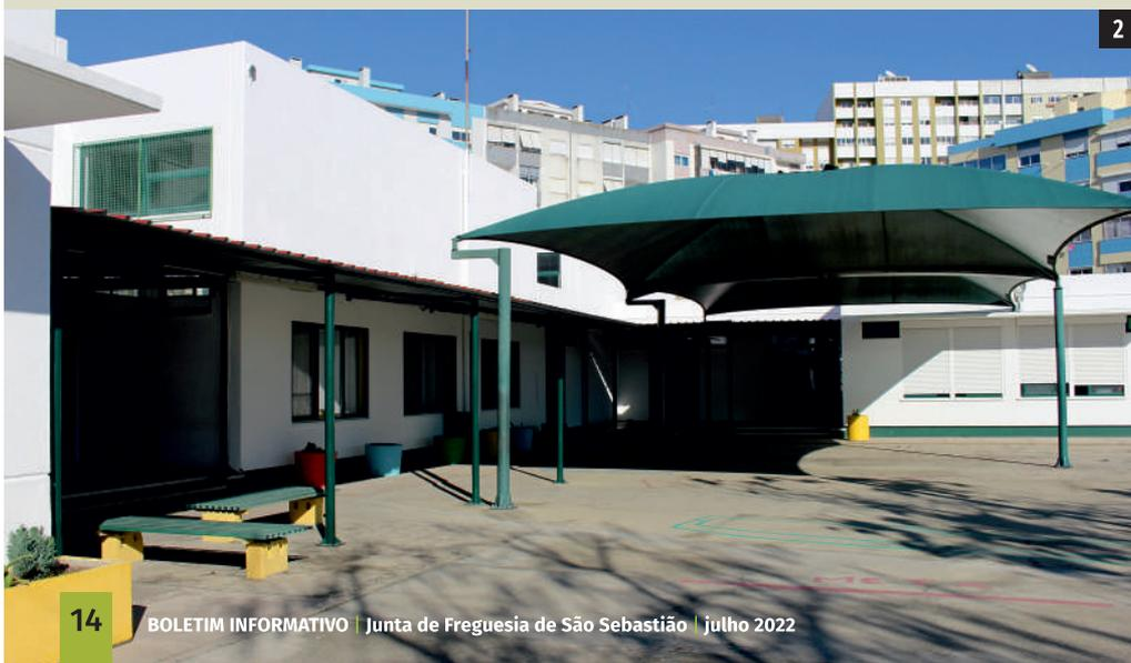
Renovámos igualmente o telheiro da Escola Básica de Monte Belo, através da substituição do revestimento pré-existente por novas chapas onduladas de zinco. A intervenção consistiu na remoção das antigas placas, que estavam obsoletas e em mau estado de conservação, por novas chapas, conferindo um maior conforto àquele espaço no pátio na escola.
